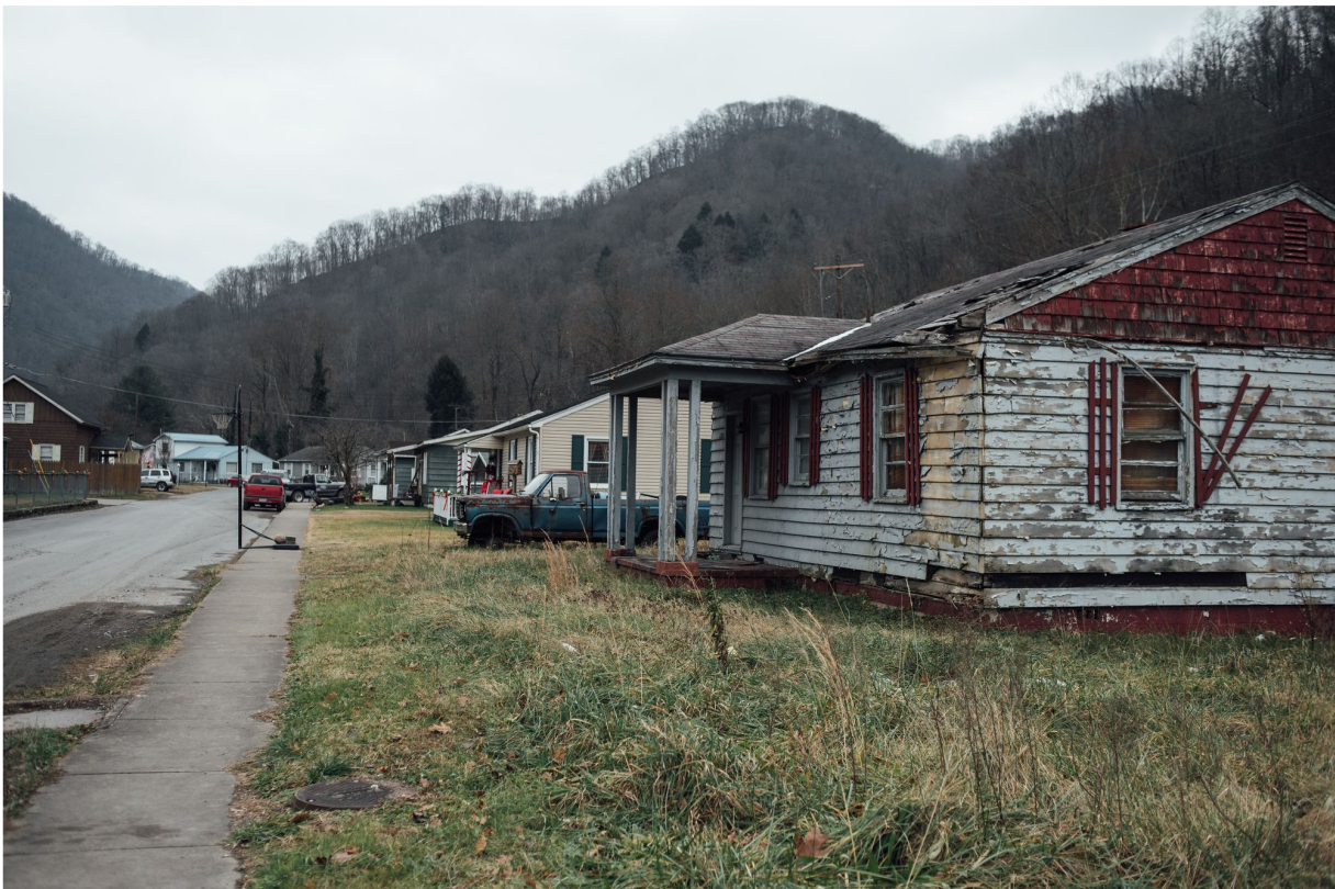
Ein Haus in der Nähe des Arbeitsplatzes: Der Traum vom Eigenheim hat sich für viele Bewohner West Virginias als Falle entpuppt. Als die Fabriken und Minen in den 1980er-Jahren reihenweise schlossen, verlor der Mittelstand den Boden – das Dach über dem Kopf an Wert.
