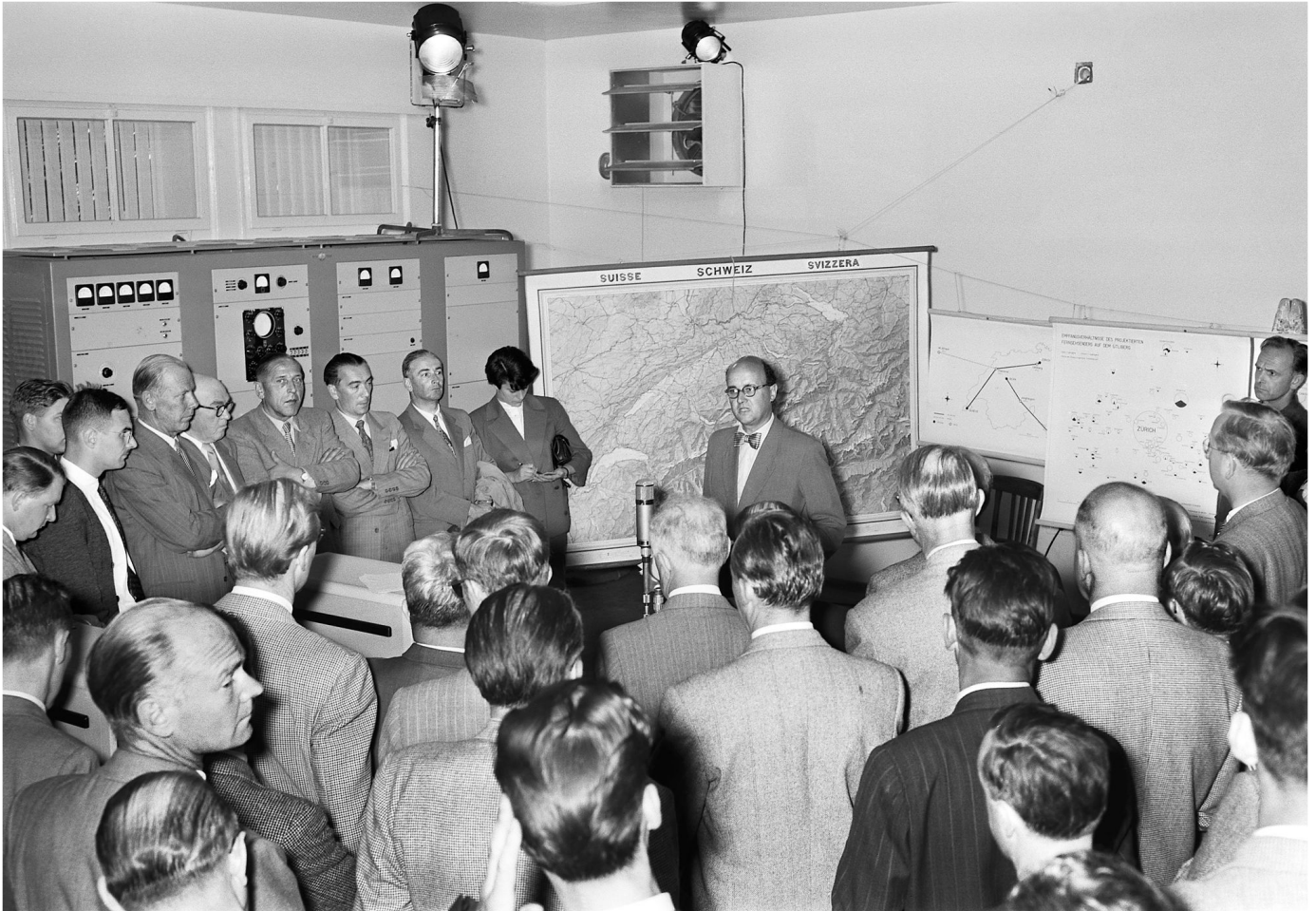
1953: Vertreter der Schweizerischen Rundspruchgesellschaft SRG bei der Eröffnung der Fernseh-Antenne auf dem Uetliberg in Zürich. Photo-press/Keystone
