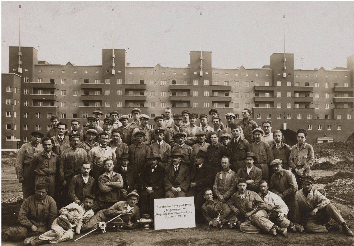
Gemeinnützige Wohnprojekte im Roten Wien: die Baugruppe für Gas-, Wasser- und Elektroanlagen vor dem Karl-Marx-Hof, ca. 1929. Wien Museum
