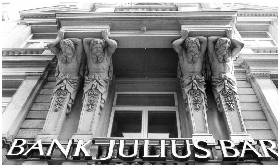
Aufnahme der Fassade der Bank Bär in Zürich aus dem Jahr 1992. Keystone
