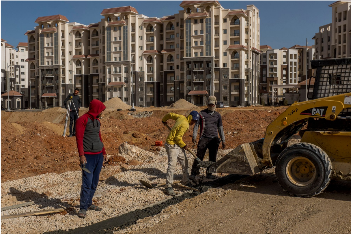
Im ganzen Land werden Präsidentenpaläste, Satellitenstädte und Gated Communitys gebaut.
