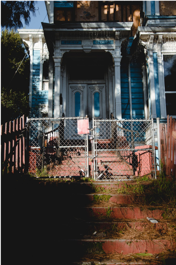
Ein leer stehendes Haus, mit schweren Schlössern verriegelt.
