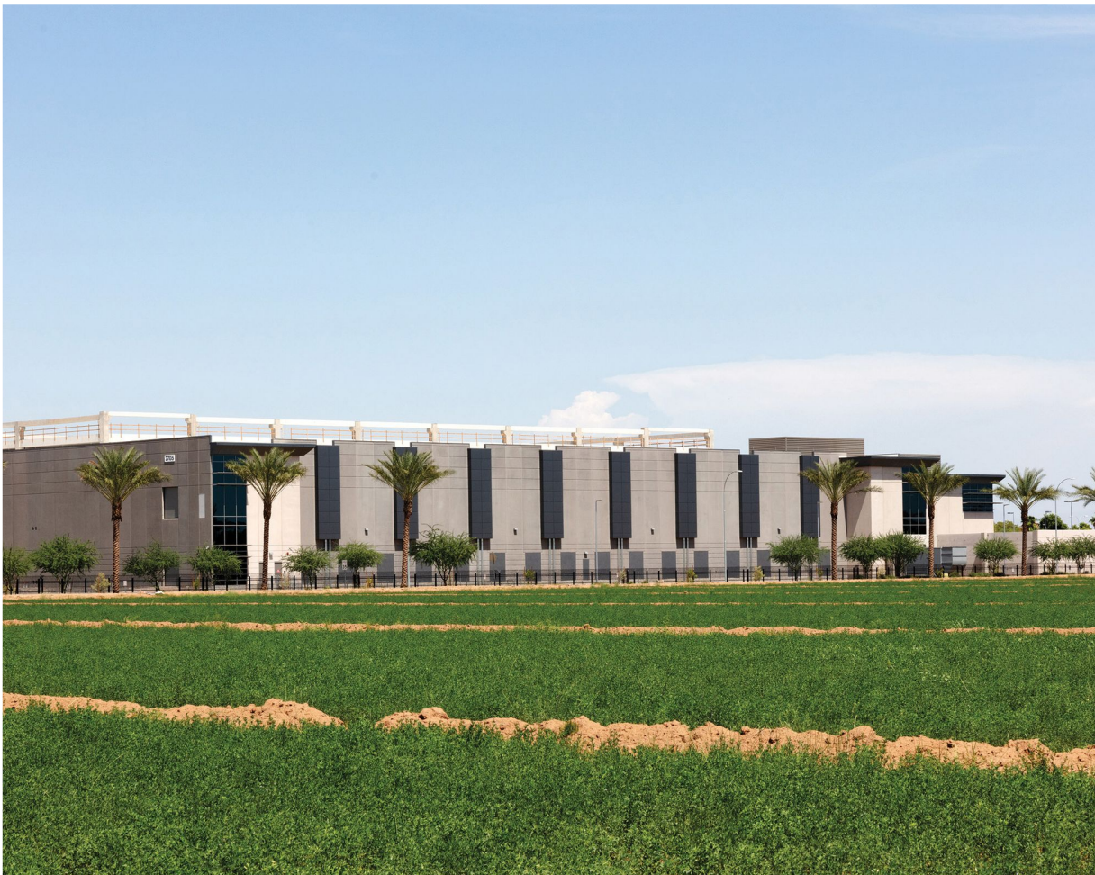
Die Server drinnen, der Lärm draussen: Das Cyrus-One-Datenzentrum in Chandler.
