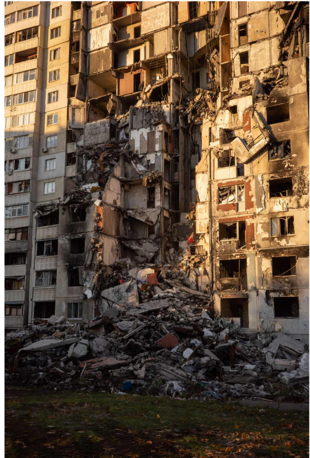
Zerstörtes Wohngebäude im Norden des Quartiers Saltiwka in Charkiw.
