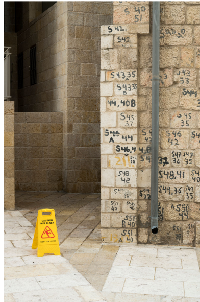
Die Steinfassade der Mamilla Mall in Jerusalem ist durchnummeriert – damit sie im Falle eines Beschusses wieder richtig aufgebaut werden kann.
