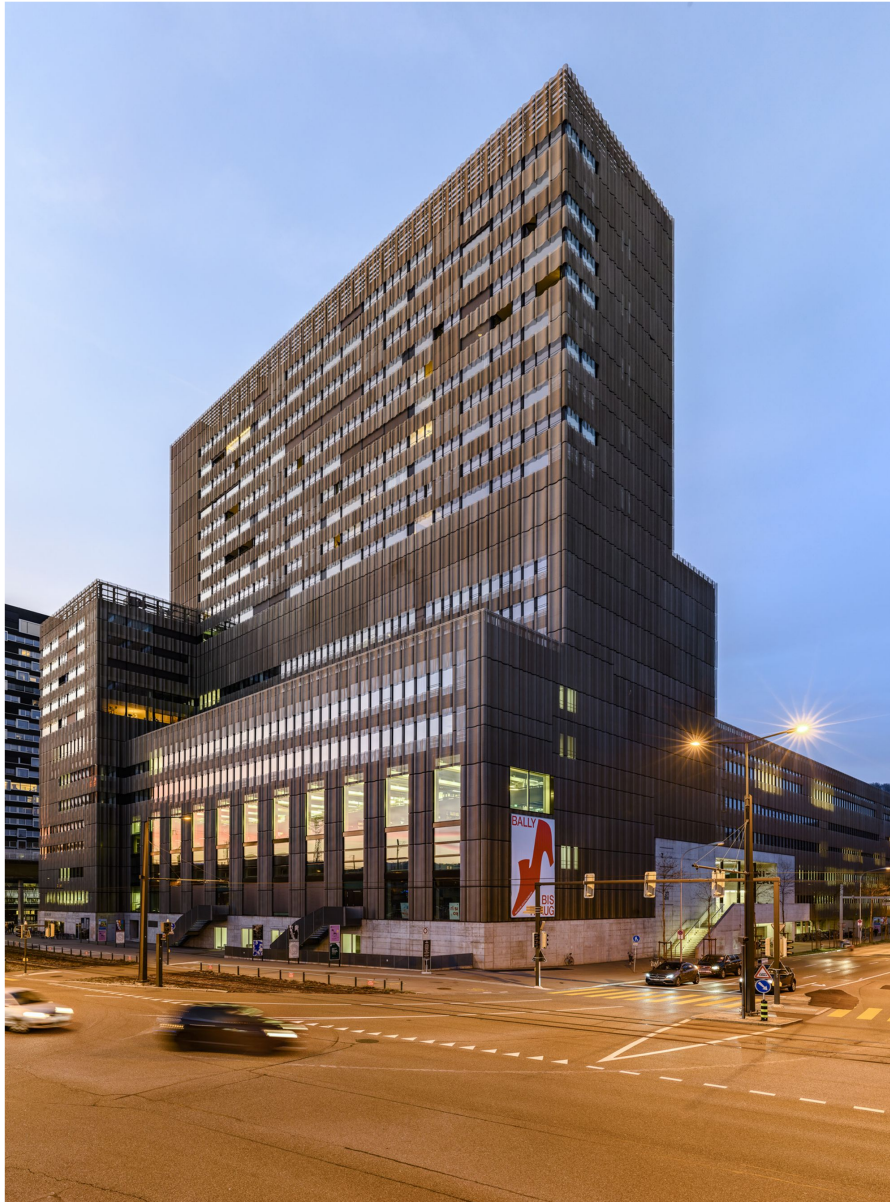
Eines der Prestigeobjekte, die sich Kurt Goger mit Dumpinglöhnen billig erkaufte: Das Toni-Areal in Zürich. Alex Buschor/Keystone
