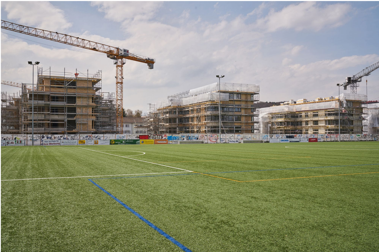
Hier wird noch gebaut: Siedlung im Zürcher Quartier Unterstrass.
