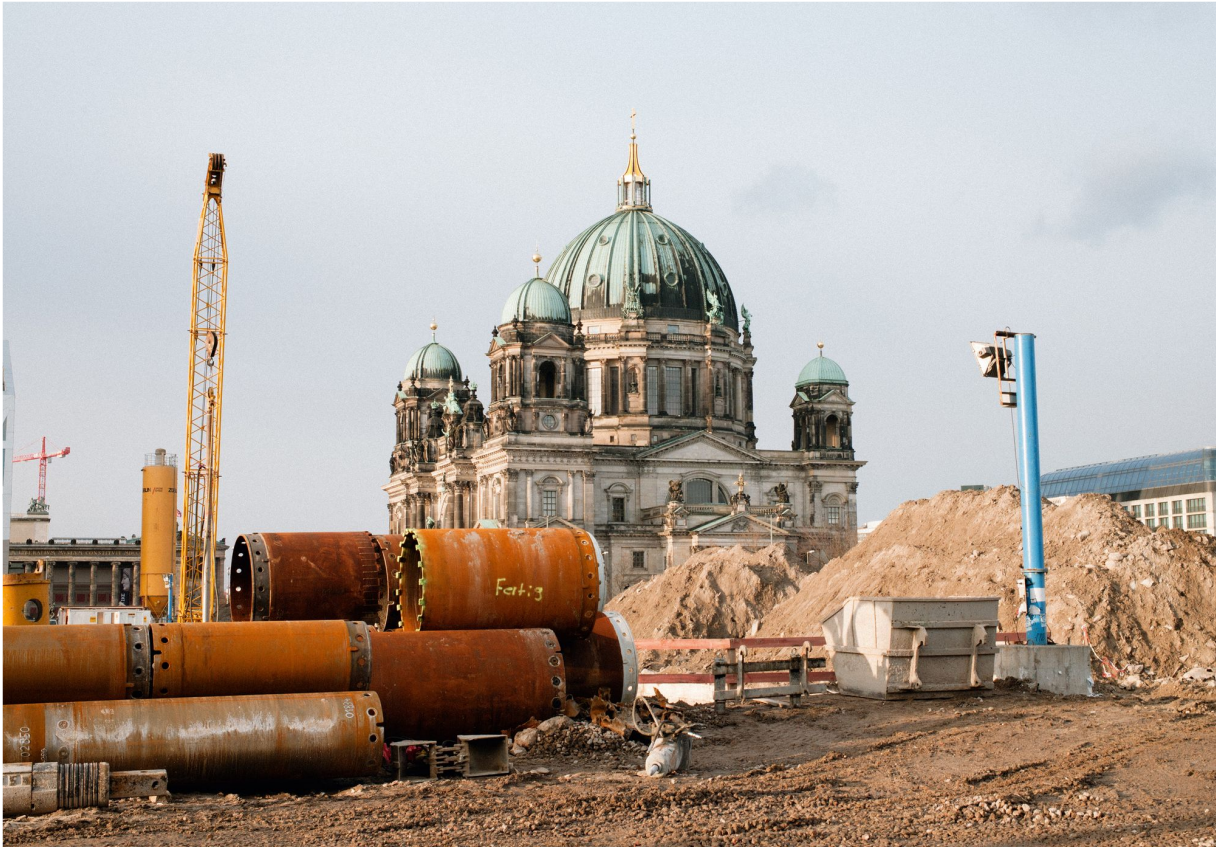
Baustelle zum Wiederaufbau des Berliner Stadtschlusses auf der Spreeinsel 2012.
