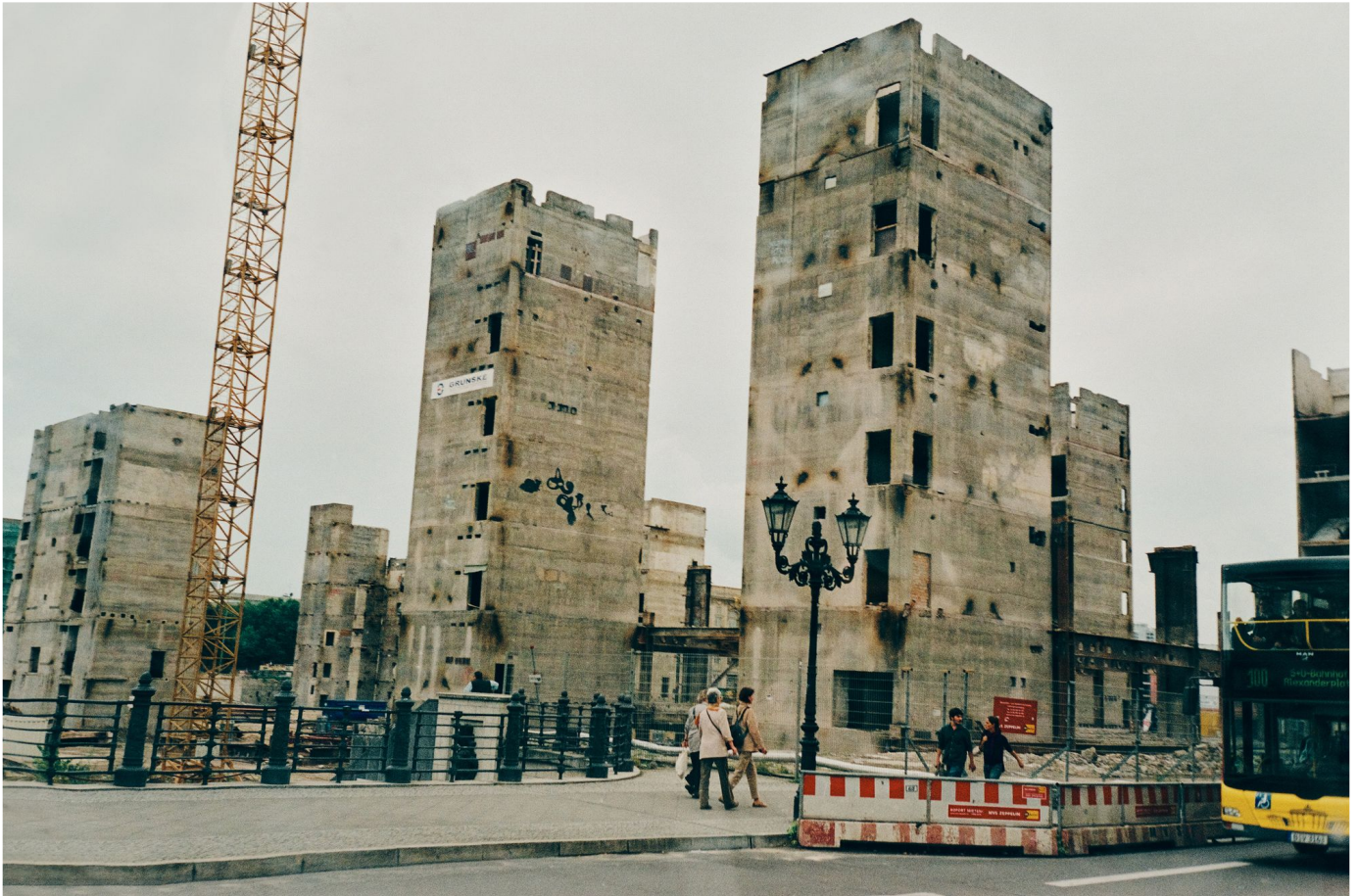
2008 wird der Palast der Republik auf der Spreeinsel abgerissen. Bilder: Christian Werner
