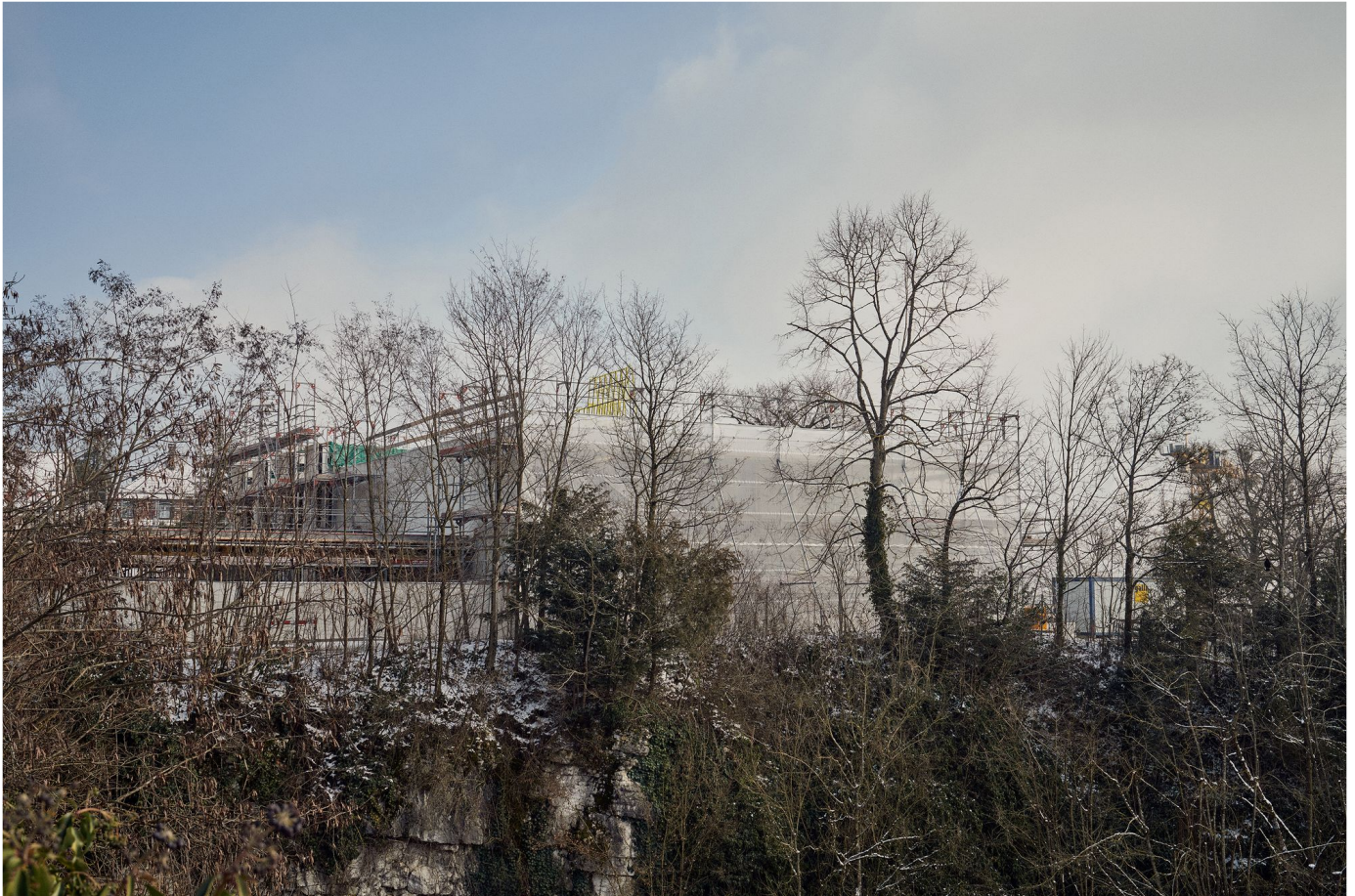
Die Bauarbeiten am Standort der früheren Villa Felsenhof: Es entscheidet die zahlende Bauherrschaft.
