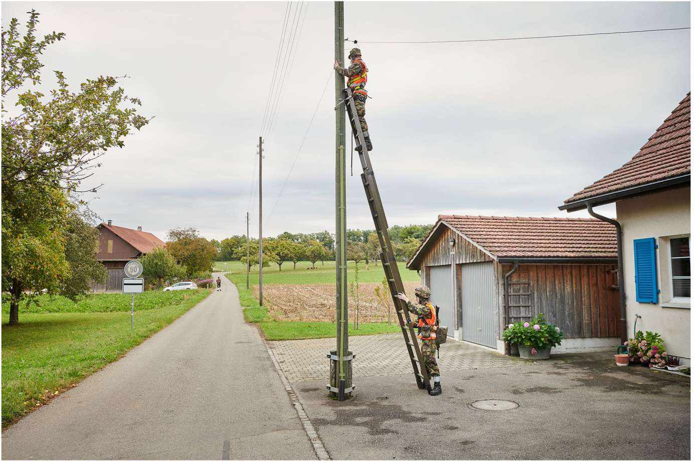
Einer fürs Kabel, einer für die Leiter und einer, der schaut, dass kein Auto kommt: Übermittlungssoldaten bei der Arbeit. Mediathek VBS/Creative Commons/CC BY-NC-ND 3.0 CH
