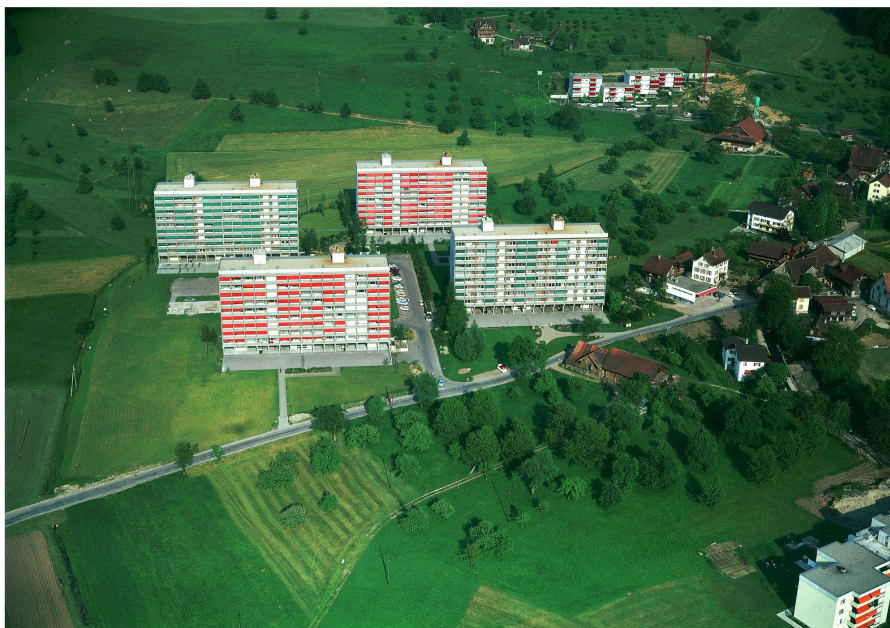
Lediglich zwei der vier Scheibenhäuser sind derart baufällig, dass die Substanz nicht mehr genutzt werden kann. Abgerissen und ersetzt werden aber alle vier. Jules Vogt/ETH-Bibliothek Zürich, Bildarchiv
