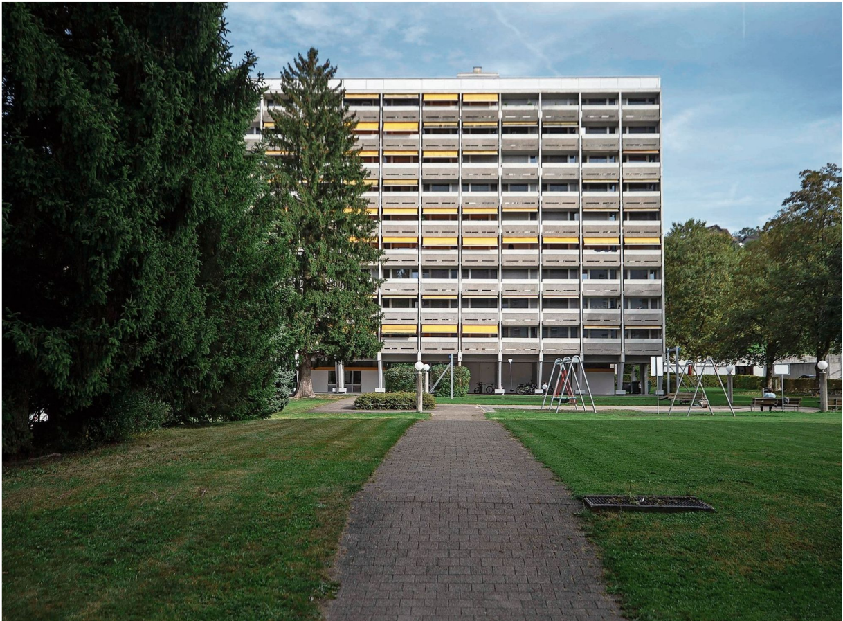
Werden abgerissen und durch Hochhäuser ersetzt: Die Scheibenhäuser in Inwil bei Baar im Kanton Zug. Stefan Kaiser/Zuger Zeitung
